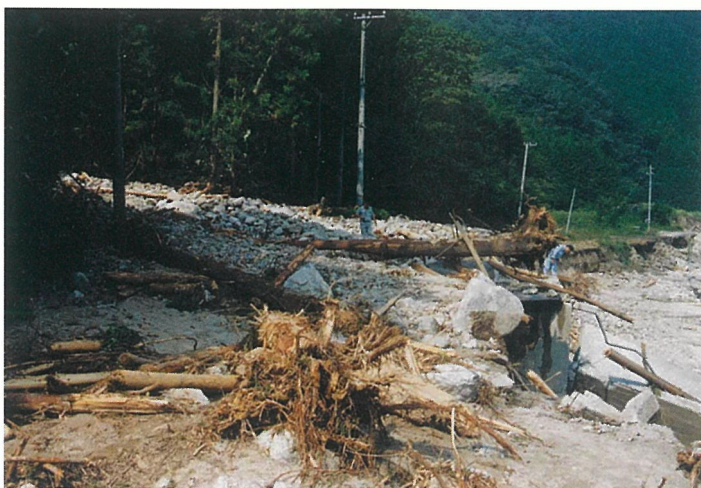
平成12年9月11～12日 黒洲谷(上矢作町下)被災状況
