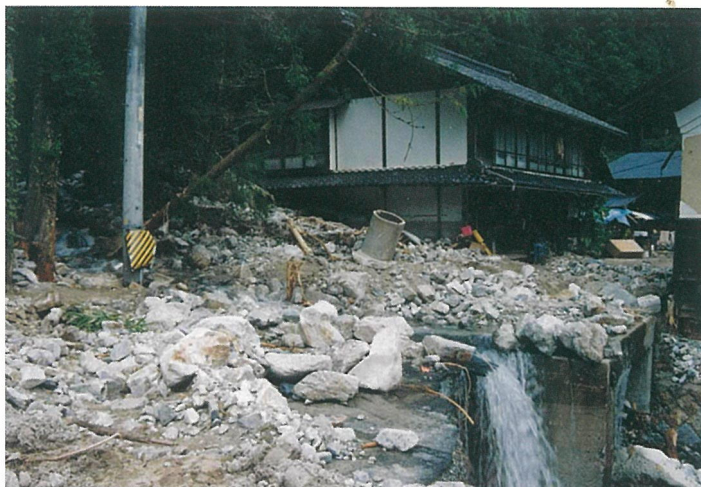
平成12年9月11～12日 犬間沢(上矢作町達原)被災状況
